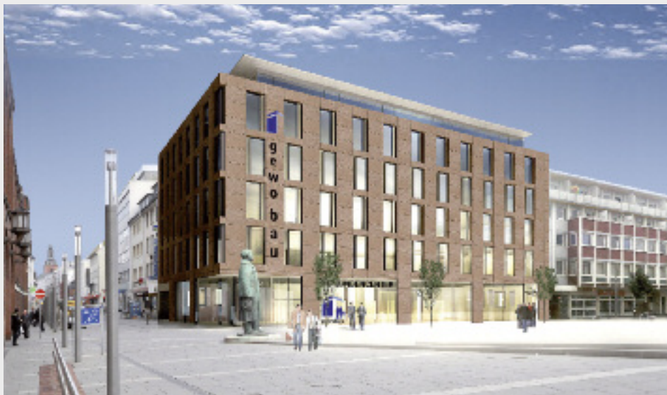
In Planung: das neue Gebäude der gewobau am Bahnhofplatz neben dem Opel-Portal
